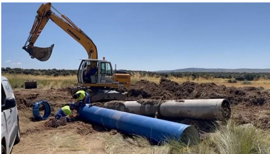
Trabajos en la conducción de agua entre Ávila y el embalse de Serones.
