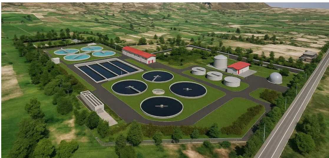
moderna planta de tratamiento de aguas residuales
